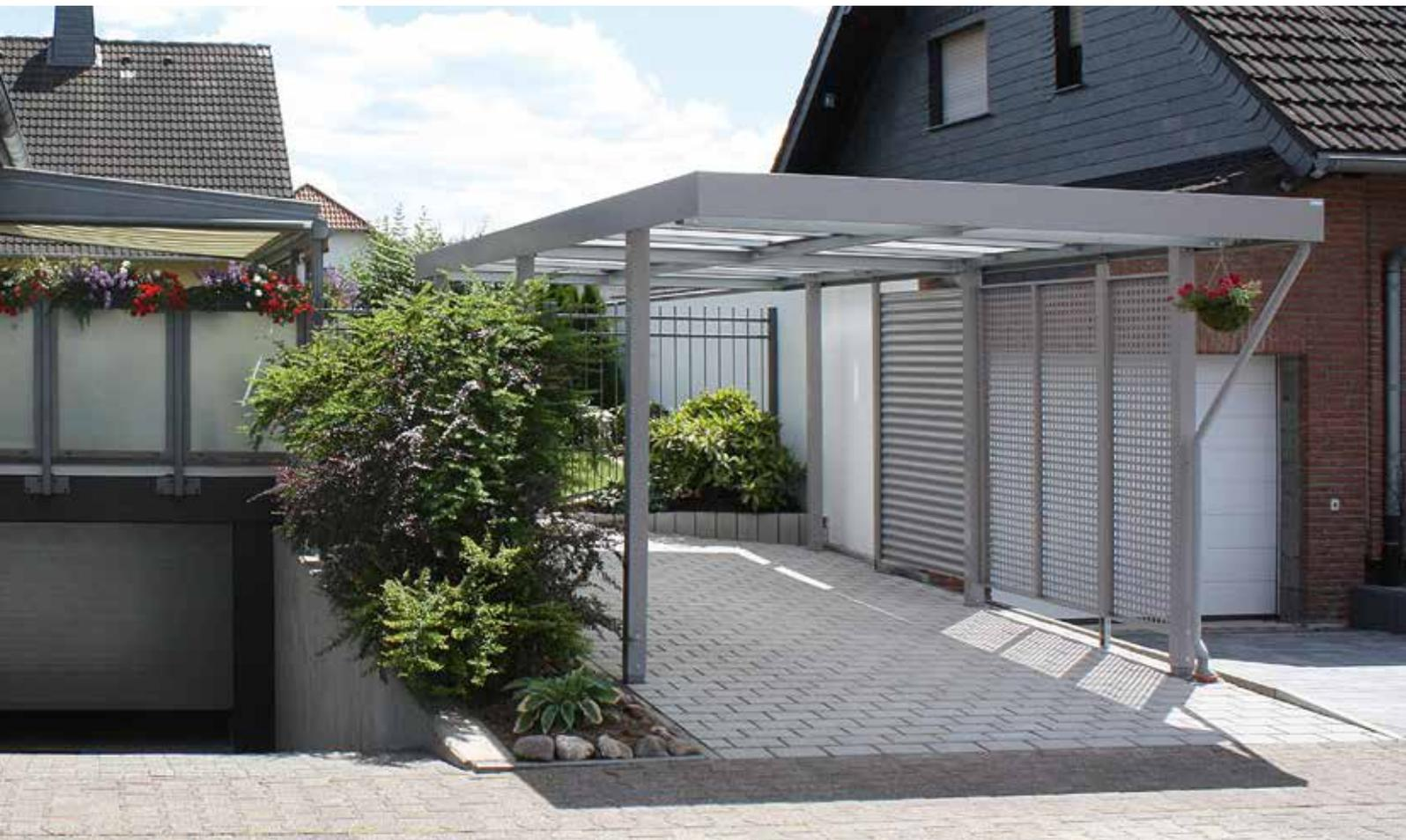
*Einzelcarport, lichtdurchlässiges Dach, seitliche Wandelemente: Stahlwelle und Quadratlochung*
