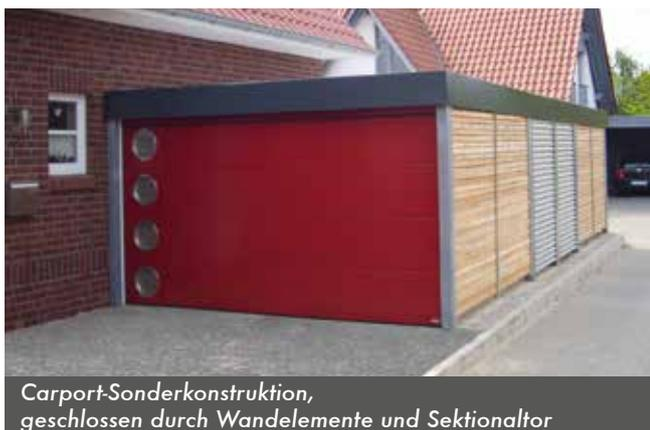
*Carport-Sonderkonstruktion, geschlossen durch Wandelemente und Sektionaltor*
